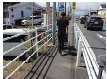
・ 道路照明が歩行空間を狭めている
