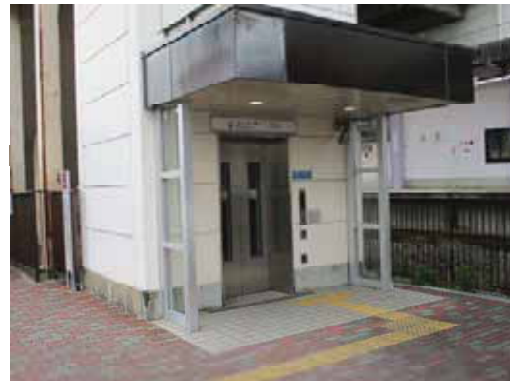
近鉄弥富駅南口 エレベーター
