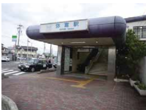
エスカレーター（北口）
