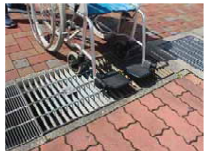
・ 溝幅の広いグレーチング蓋
