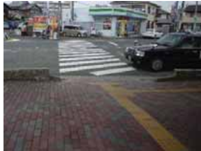
駅前ロータリー (視覚障害者誘導用ブロック)
