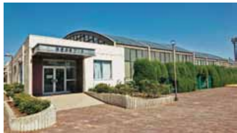
▲解体される市民プール
