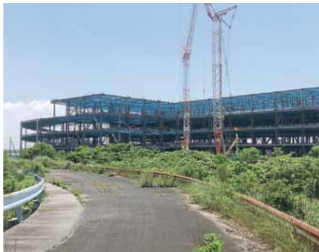
▲駒野地区で建設中の物流施設
