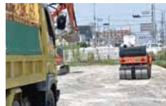
▲作業中の国道155号予定地
