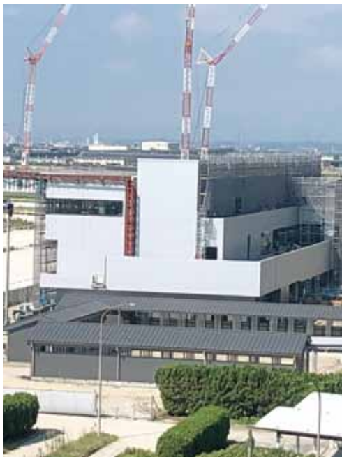
▲建設中の名古屋競馬場
