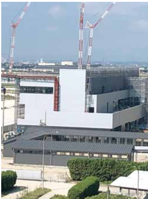
▲建設中の名古屋競馬場
