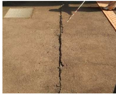
屋外：舗装不陸
