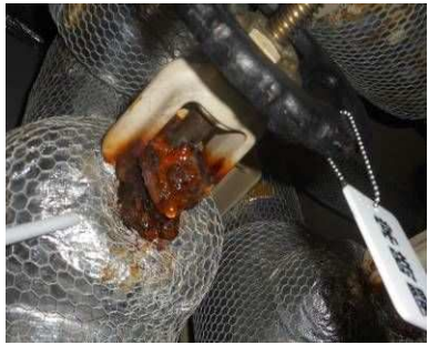
機械：配管バルブ錆
