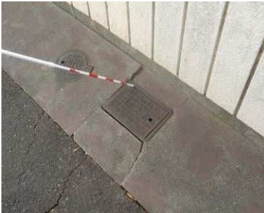
屋外：散水栓廻り沈下
