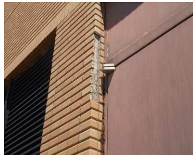
外壁：タイル欠落
