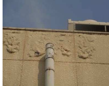
外壁：塗装浮き
