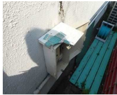
電気：中継ボックス破損
