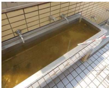
機械：排水不良
