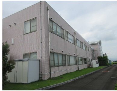
外壁：漏水及びシーリング劣化
