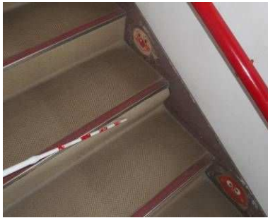
内装：蹴上浮き
