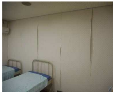
内装：クロス捲れ（全体）
