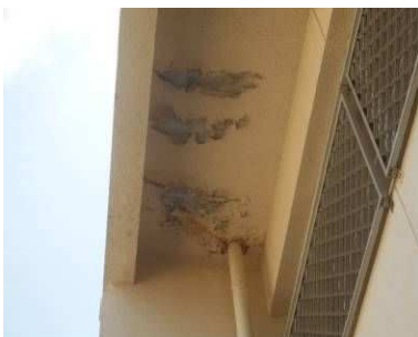
軒裏：塗装剥がれ
