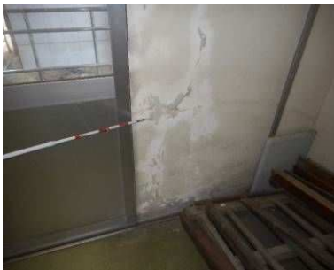
内装：塗装剥離 (複数)
