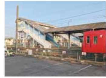
▲JR・名鉄弥富駅跨線橋
