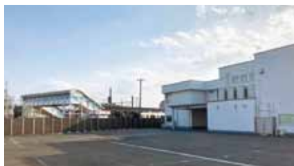
▲弥富駅北口駅前広場予定地 (JA会館やとみ周辺)
