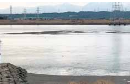
▲尾張大橋北側（小島町）から見た木曾川河床
