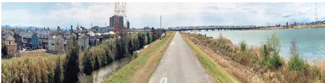
▲木曽川と家屋倒壊等氾濫想定区域
