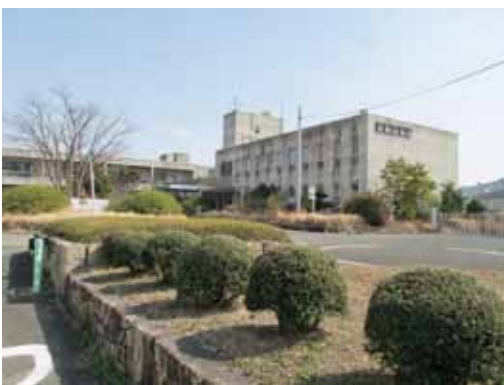
▲愛知県農業総合試験場跡地 (前ヶ平)
