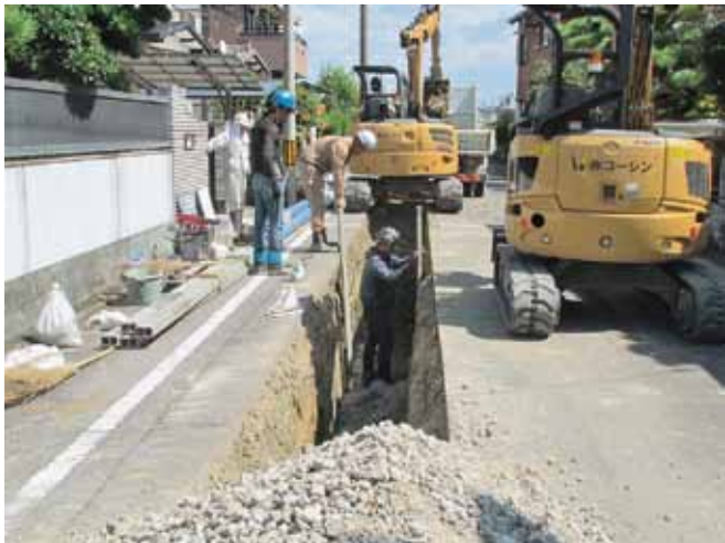
▲下水道工事の様子
