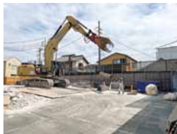
▲解体中の旧歴史民俗資料館
