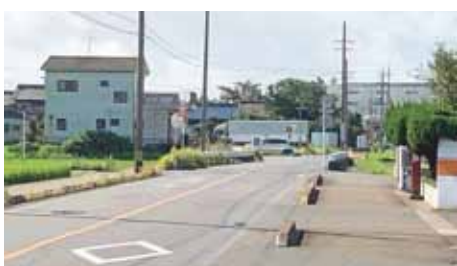
▲鋳物工場付近（中央幹線の未整備区間）
