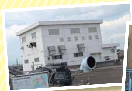
▲新孫宝排水機場
