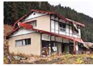
▲飛騨市内の空き家
