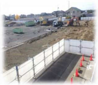
運動場西側が 工事エリアです。
