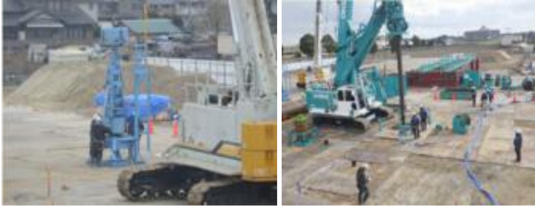
【1月14日（水）掘削工事の開始】
