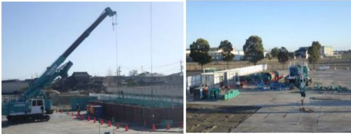
【2月19日（木）新築校舎の基礎づくり完了】
