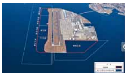
▲新土砂処分場(セントレア)
