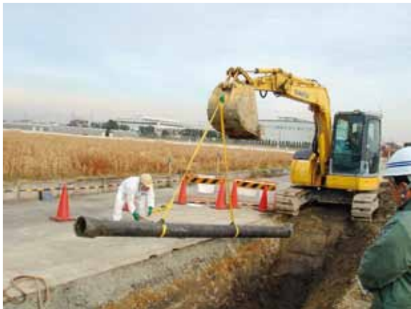
▲石綿管入れ替え工事
