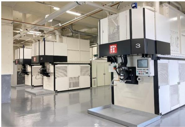
最新の排ガス処理設備を備える火葬炉
