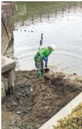
▲水路への土砂投入
