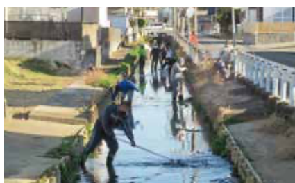
▲水路清掃の様子
