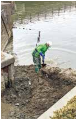
▲水路への土砂投入
