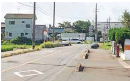
▲鋳物工場付近 (中央幹線の未整備区間)
