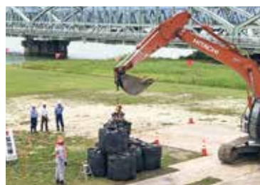
▲尾張大橋・大型土のう設置訓練
