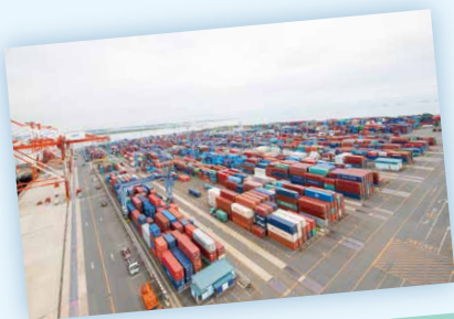
鍋田埠頭コンテナターミナル
