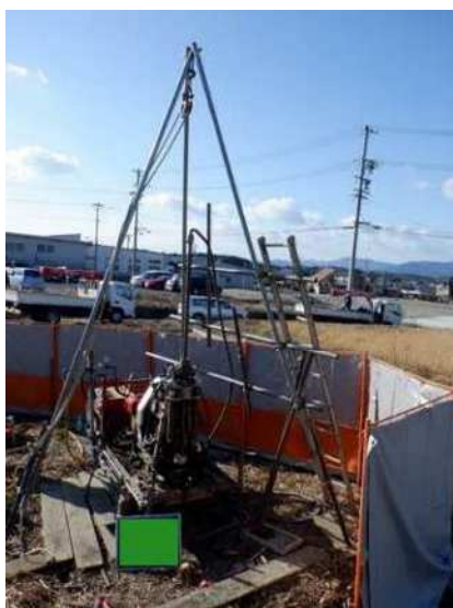
ボーリング調査作業状況
