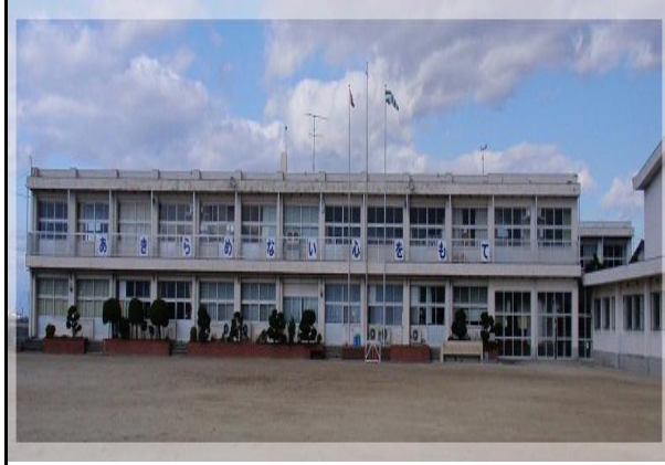
校舎等の外観写真
