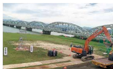
▲大型土のう設置訓練 (令和5年5月)
