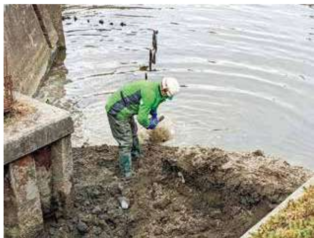
▲佐古木地区揚水ゲート改修事業
