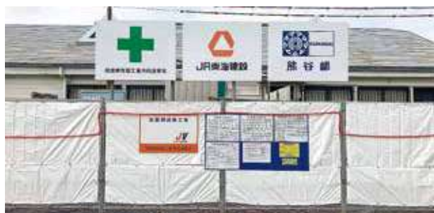
▲ JR 名鉄弥富駅自由通路及び橋上駅舎化工事風景
