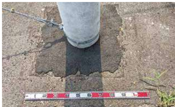
▲電柱基礎工事
