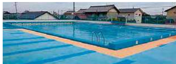
▲弥生小学校のプール
