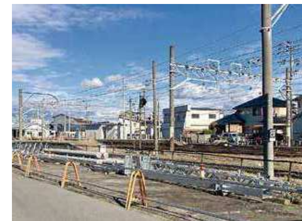
▲工事中のJR弥富駅
