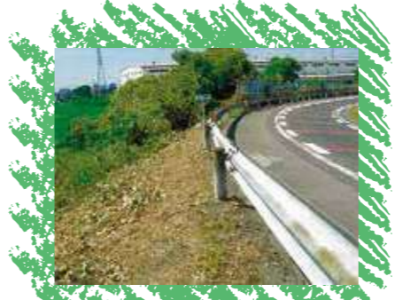
【東名阪自動車道弥富 インターチェンジ 緊急時避難場所整備工事 2,000万円】
