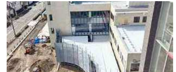
▲工事中の「みなともまちなか交流館」
