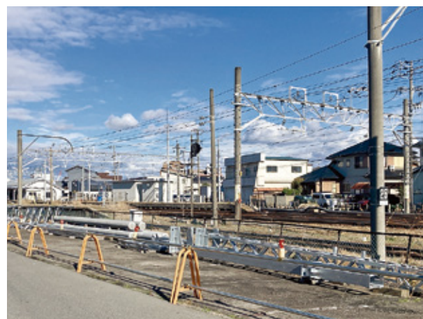
▲工事中のJR弥富駅
