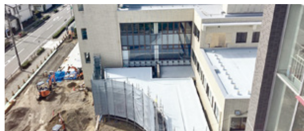
▲工事中の「みなともまちなか交流館」
