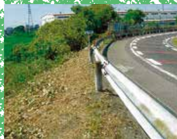
【東名阪自動車道弥富 インターチェンジ 緊急時避難場所整備工事 2,000万円】
