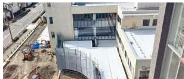
▲工事中の「みなともまちなか交流館」
