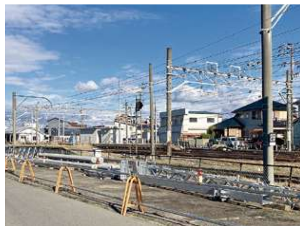
▲工事中のJR弥富駅
