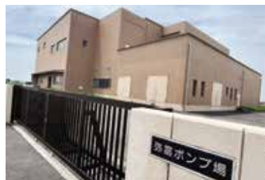
▲弥富ポンプ場
