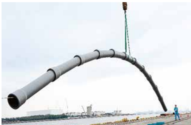
ダクティル鑄鉄管GX形吊り上げ写真
