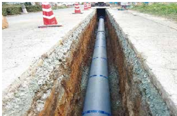
ダクティル鑄鉄管GX形施工写真
